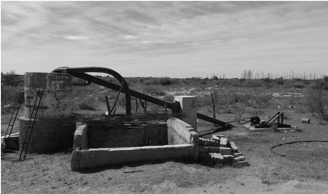
Figura 41. Pozo excavado para extracción de agua y circuito de mangueras para su distribución, puesto 17. Fuente: Sales, 2016.
