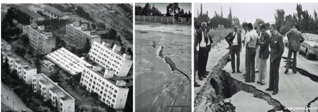
*Fig. 23. Imágenes ilustrativas de los efectos de la licuación debida a terremotos severos. Izquierda: Terremoto de Nigata-Japón (año 1964, fuente: USGS). Centro y Derecha: Terremoto de Caucete-San Juan (año 1977, fuente: INPRES).*
