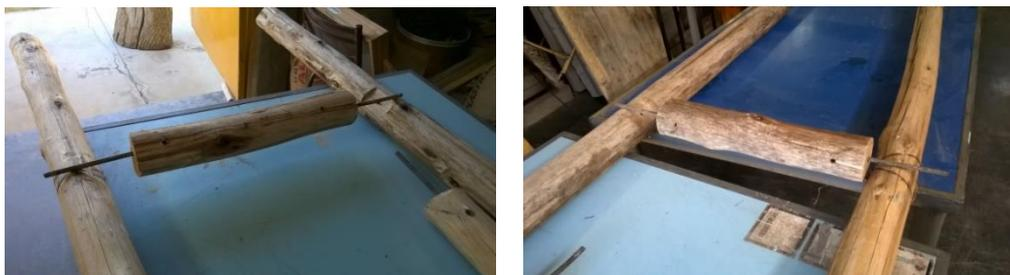
*Fig. 54. Empalme con utilización de varilla de hierro*
