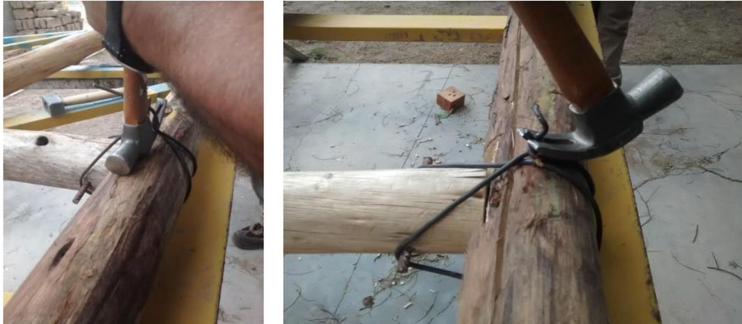
*Fig. 53. Empalme utilizando alambre*
