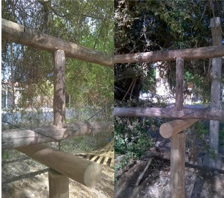
*Fig. 57. En la imagen se muestra como queda conformado el nudo entre columna, tirante y cercha.*
