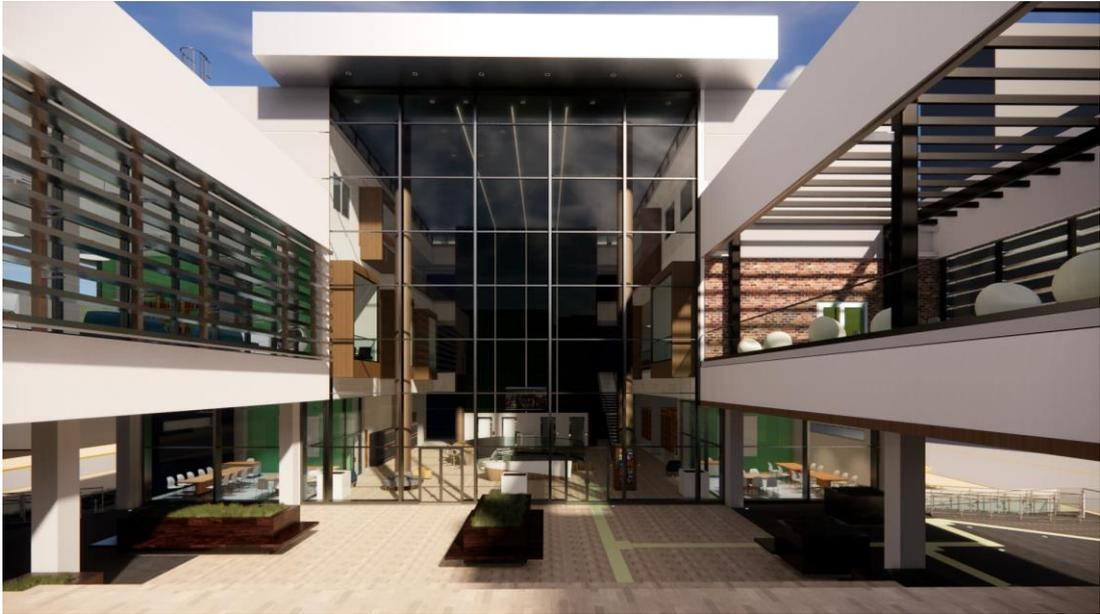
Estudio solar, se realizó de manera tal de analizar el comportamiento del sol en las distintas épocas del año para determinar los parasoles necesarios en la fachada del edificio.
