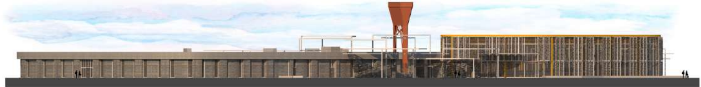
Vista oeste - calle Salta
