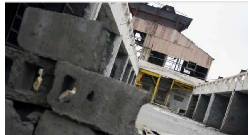
Vista interior de la Bloquera abandonada
