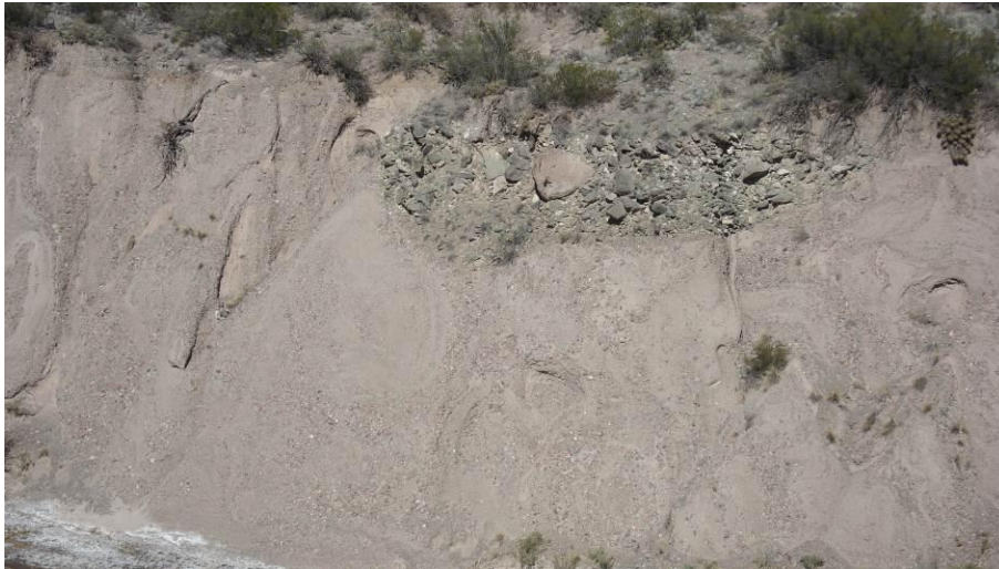
Foto N° 158 Vista de un depósito de la asociación A5 cortado por un canal moderno.
