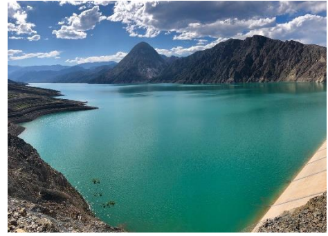
(Dique Punta Negra, San Juan)
